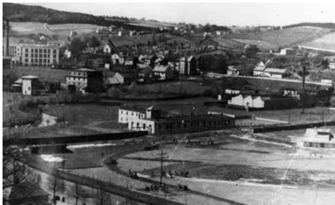
1938 ATAS – sídlo firmy Na Hamrech po r. 1937
