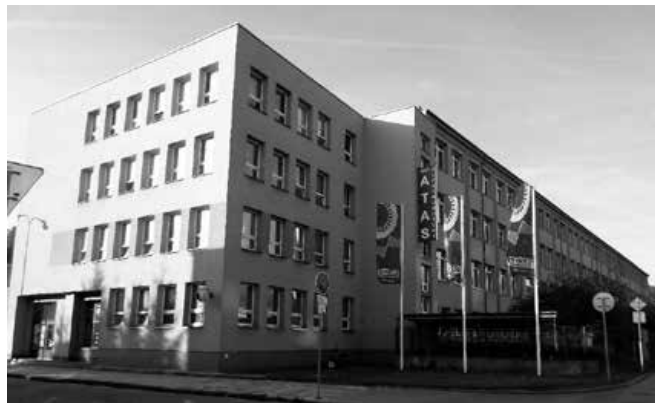
Současný vzhled sídla firmy v ulici Bratří Čapků
