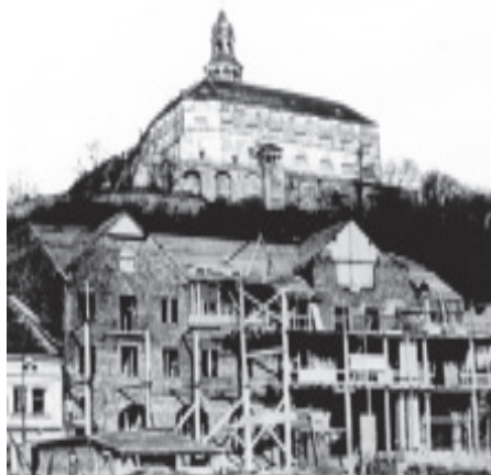
Stavba městského divadla
